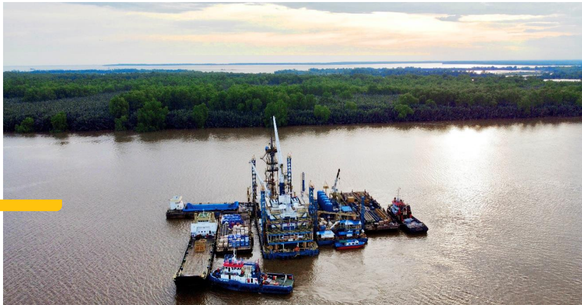
Barge ELSA-8 yang merupakan barge utama dalam pengeboran menggunakan HWU.
