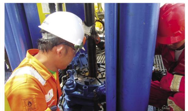
Beberapa perlengkapan yang digunakan di *rig* telah dimodifikasi dan disesuaikan untuk dipasang di HWU agar ia dapat digunakan untuk instalasi peralatan operasi MZST-GP. Karena unit HWU ukurannya kecil (*small footprint*), ia cocok dioperasikan di lokasi yang sempit di area rawa-rawa.
