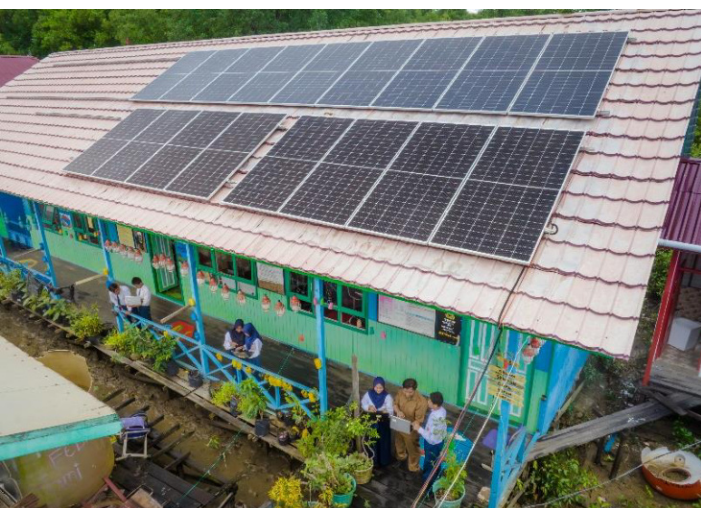
Solar Home System di SMPN 06 Anggana.
