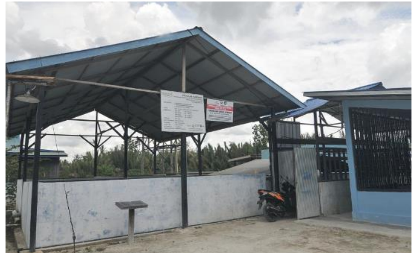
Fasilitas penampungan Air WSS Saliki.
