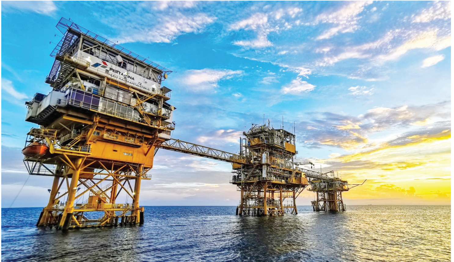
Sepinggan Platform merupakan salah satu wilayah operasi PT Pertamina Hulu Kalimantan Daerah Operasi Bagian Selatan (PHKT-DOBS)
