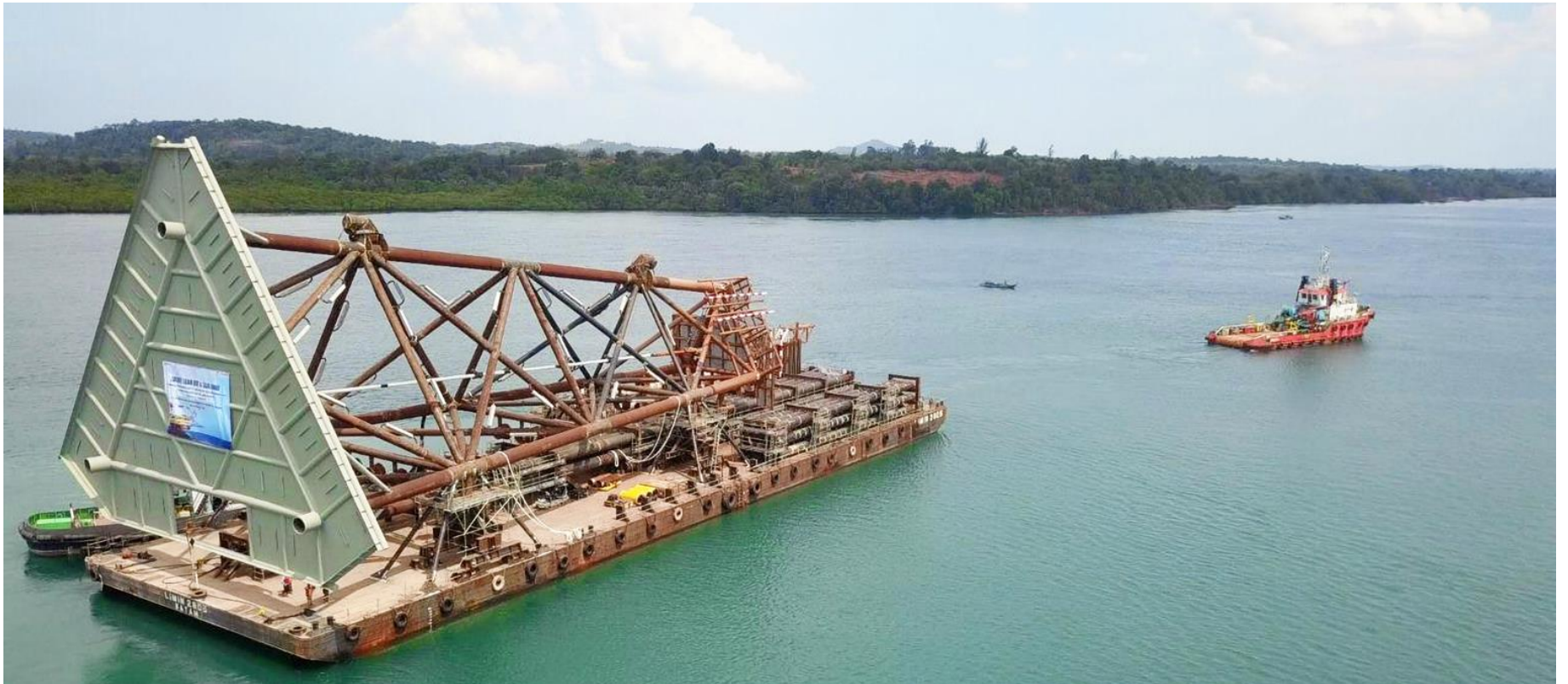
Sailaway jacket (kaki) anjungan lepas pantai untuk proyek Jumelai, North Sisi, dan North Nubi (JSN). Proyek pembangunan tiga anjungan lepas pantai yang memiliki nilai investasi USD 105 juta (diluar biaya pengeboran), ditargetkan dapat mendukung 20% produksi WK Mahakam pada 2024.
