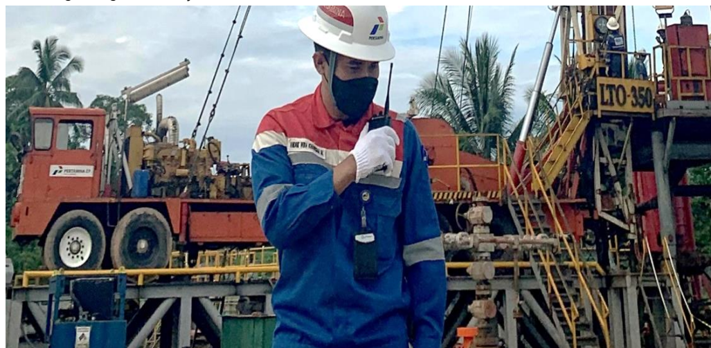
Andrie, saat sedang melakukan koordinasi dan pengawasan perbaikan power tong di lokasi Rig LTO-350 sumur B-144 Bunyu Field.
