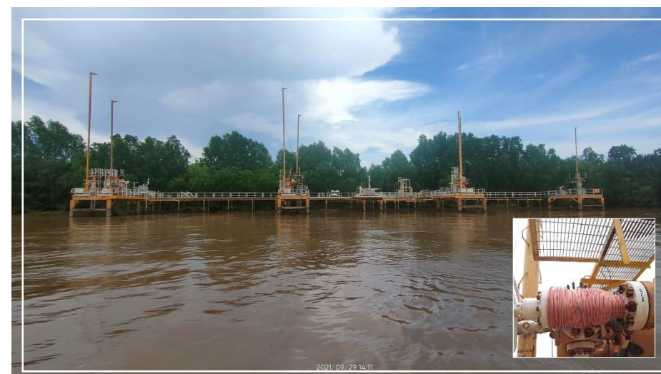
Contoh pemasangan Spiral Tube di Sumur H-XA-354-S1, Lapangan Handil
