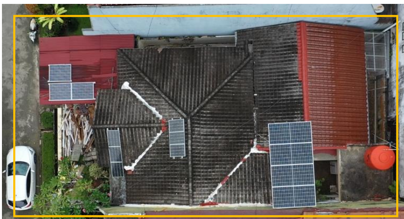
Pemasangan solar panel tata surya di rumah Johannes Anton Witono.
