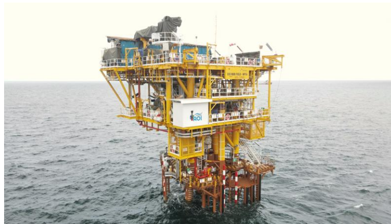
Keberhasilan Proyek SNB AOI ditandai dengan on stream Sumur SS-401 di Platform WPS4 pada tanggal 4 Desember 2025
